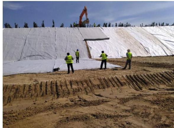
6mm 厚 GCL 膨润土垫膜下保护层
