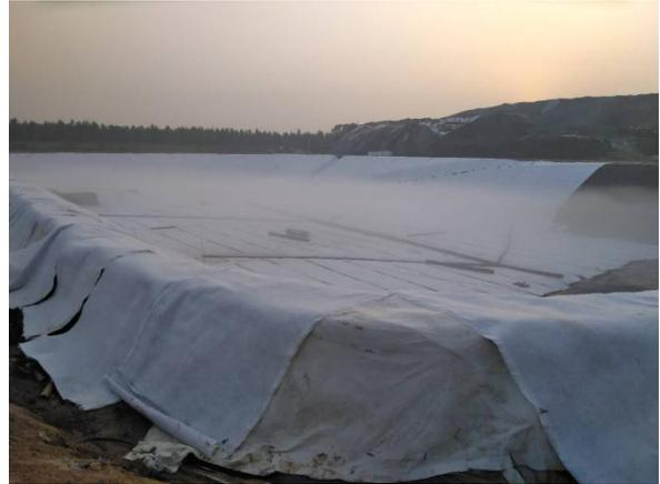
**1400g/m<sup>2</sup> 土工复合排水网及 400g/m<sup>2</sup> 长丝无纺布膜下保护层**
