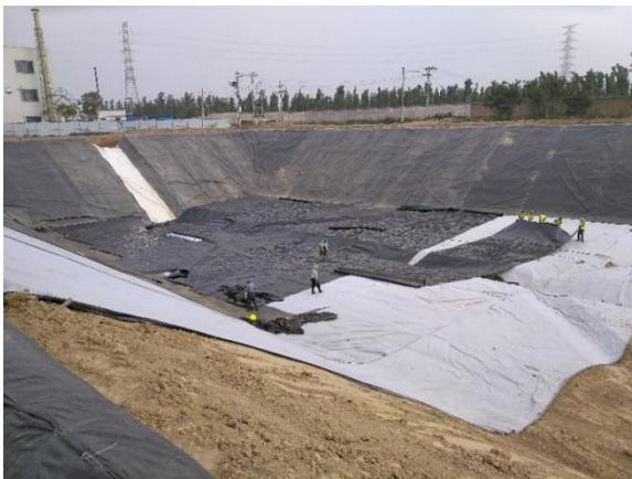
1.5mm 厚光面 HDPE 土工膜主防渗层
