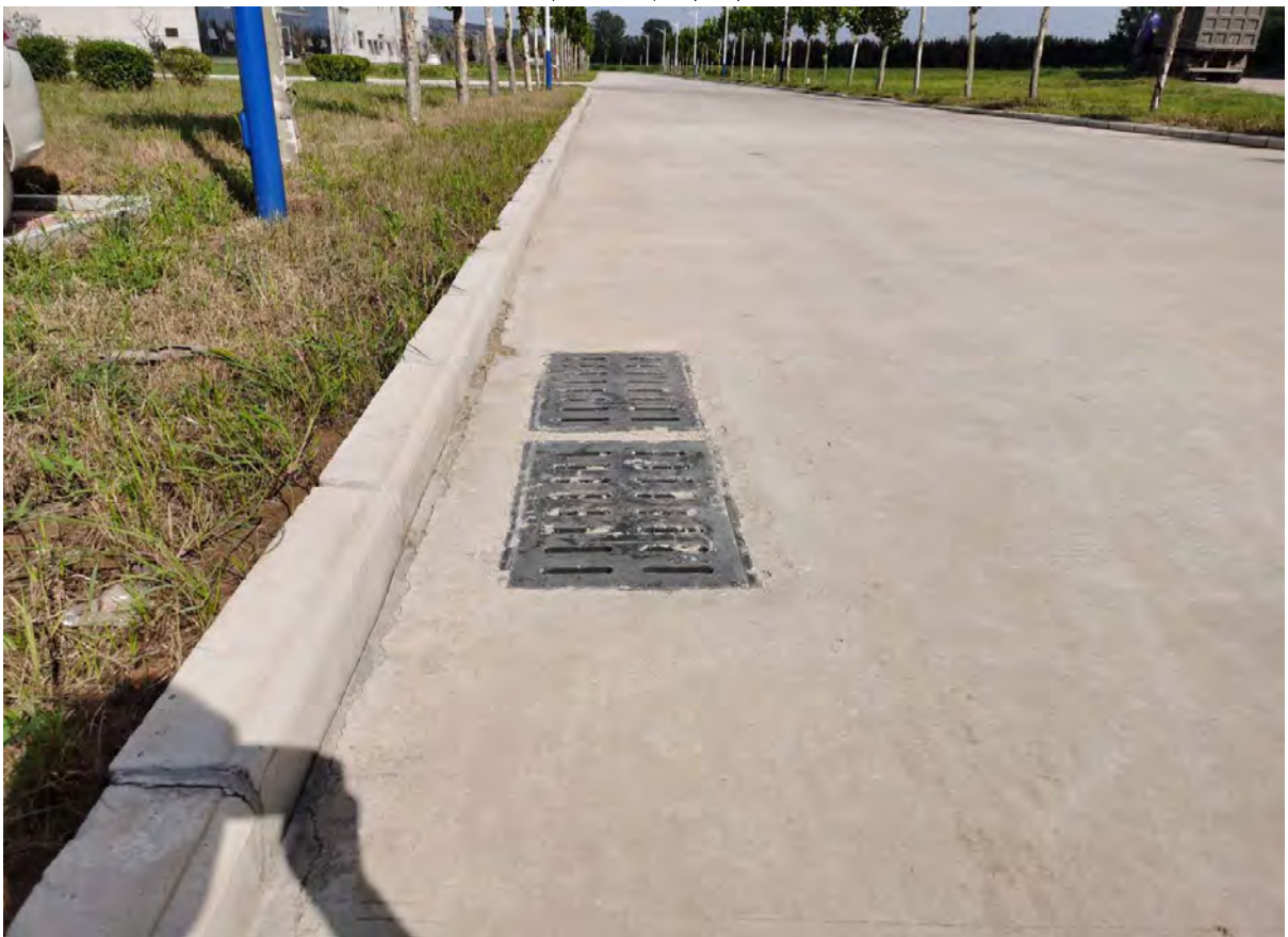
管理区排水工程
