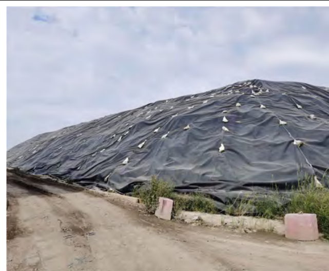
垃圾堆放区 PVC 膜覆盖
